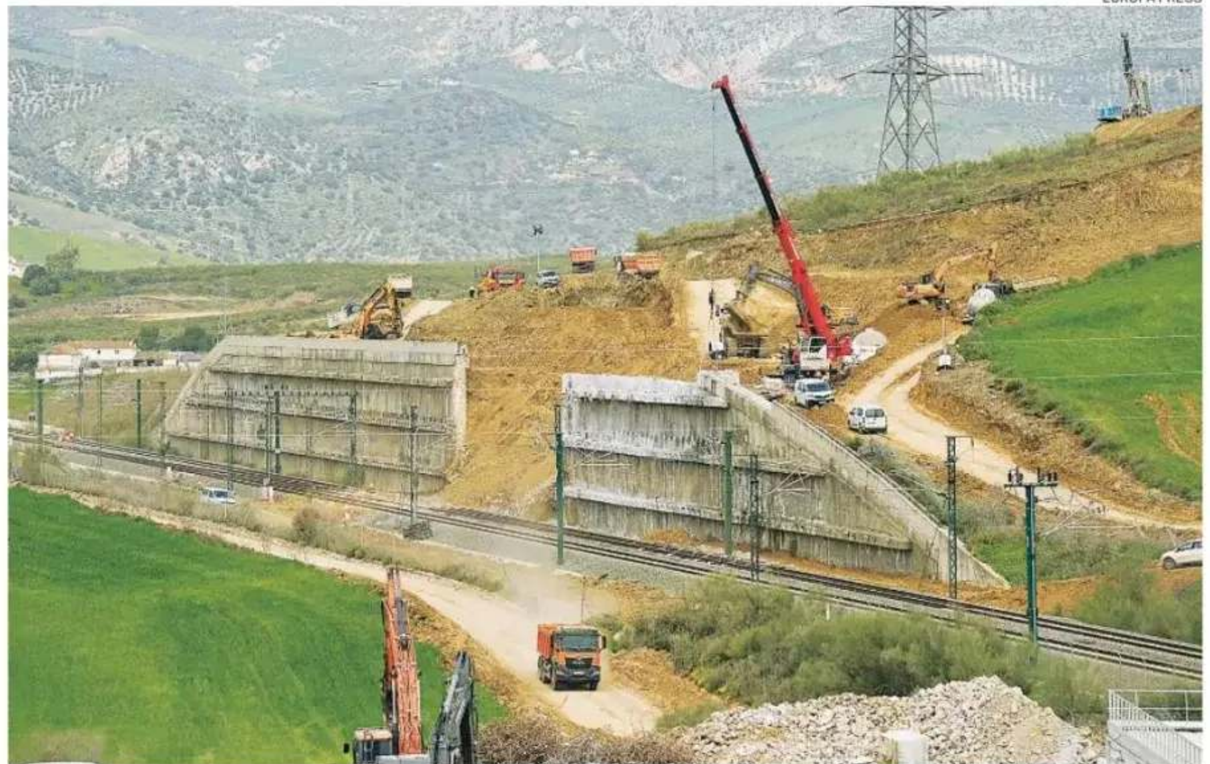
Obras en el tramo de alta velocidad en dirección a Málaga
